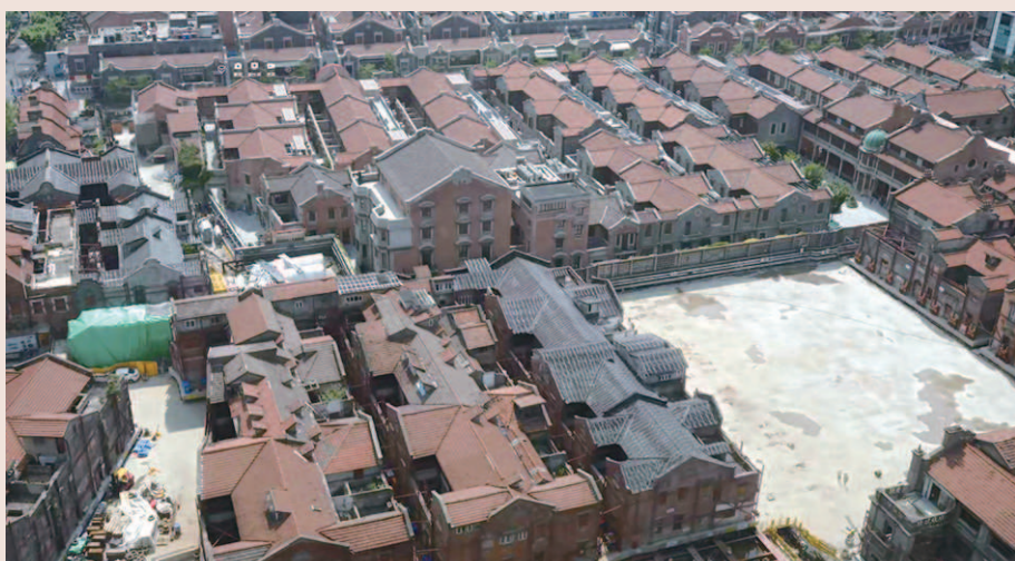
432个小型步履式移位机器人拖着7500吨的“华严里”以日均10米的速度前进 上海建工二建集团供图
