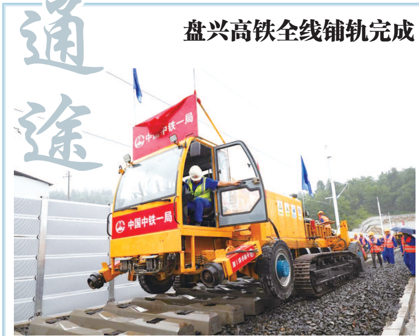
盘兴高铁全线铺轨完成 7 月 22 日，随着最后一根 500 米长钢轨平稳铺设在位于贵州省盘州市的茶厅左线隧道路基上，盘兴高铁全线铺轨贯通。 盘（州）兴（义）高铁是贵州实现“市市通高铁”目标的最后一个项目，北起盘州站，南至兴义南站，全长约 98 公里，预计 2025 年底建成通车，建成后将实现贵阳至兴义 2 小时内直达，对促进区域经济发展具有重要意义。 图为当天，中铁一局建设者在接轨处进行铺轨施工。 新华社图/文
