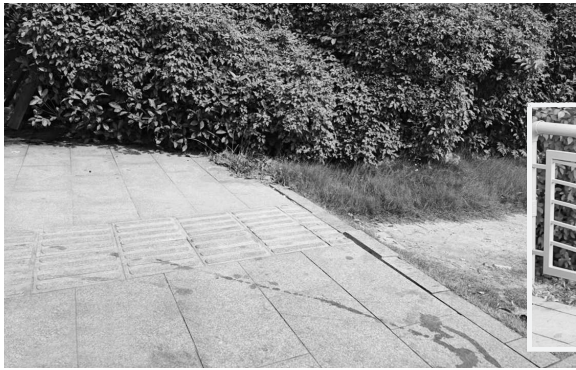
◀盲道在绿化带前中断，且连接处有高度差 ▼目前该盲道处增加了围挡
